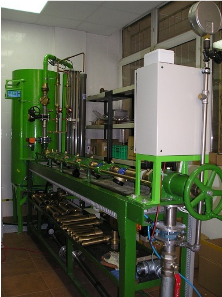
2. stanowisko do sprawdzania wodą ciepłą wodomierzy oraz przetworników przepływu do ciepłomierzy do wody o zakresie średnic (15÷40) mm,
